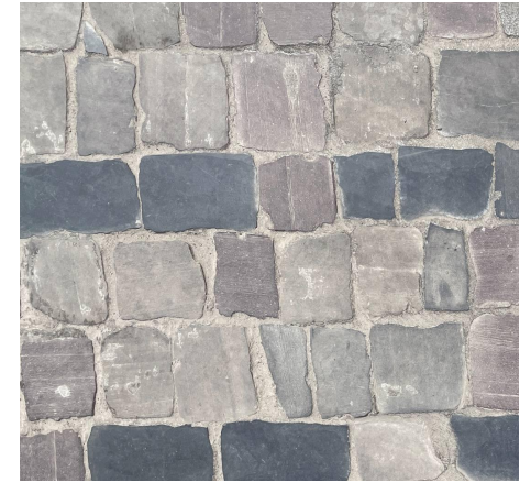
Бруківка натуральна пиляна. В умовах історичного середовища, з метою збереження автентичної бруківки.
